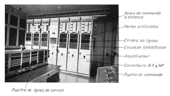
Fig. 11. Equipement radiophonique de la station de répéteurs de Zurich.
