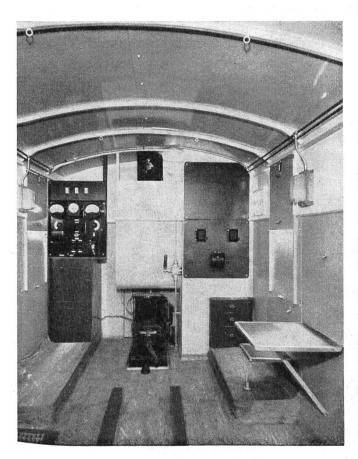
Abb. 2. Die Stromlieferungsanlage.
