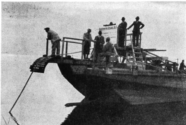
Abb. 4. Kabelversenkung.
