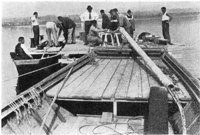
Abb. 6. Montage der Pupinmuffe.
