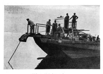
Abb. 4. Kabelversenkung.
