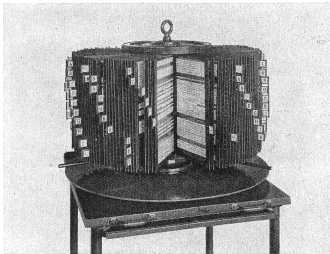
Fig. 2. Sichtstreifenanlage zu einer Trommel für 50000 Adressen.
