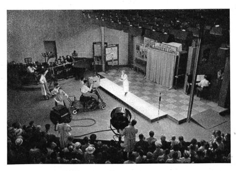
Abb. 1. Fernsehbühne der Deutschen Reichspost. Die Erscheinung der Darstellerin wird mit dem elektrischen Bildfänger aufgenommen und der Ton mit dem Mikrophon.
