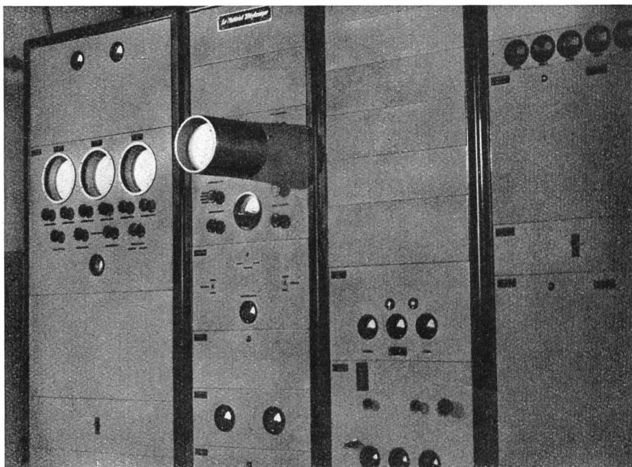
Fig. 4. Abschlusseinrichtungen und Kontrolllempfänger. — Equipements terminaux et récepteur de contrôle.
