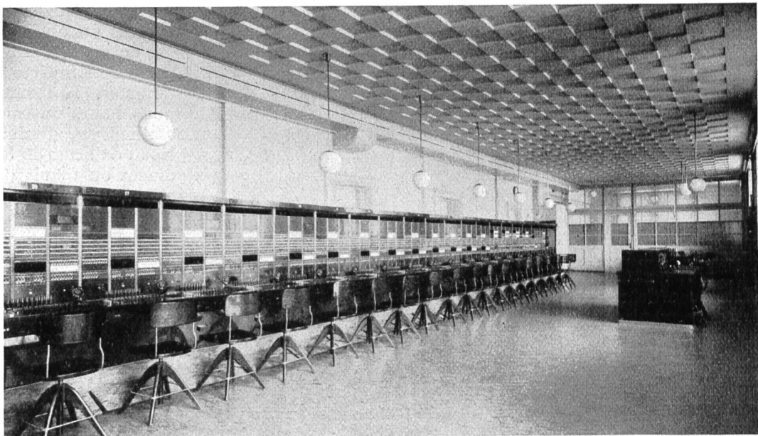
Fig. 8. Neues Fernamt St. Gallen. — Nouveau central interurbain de St-Gall.
