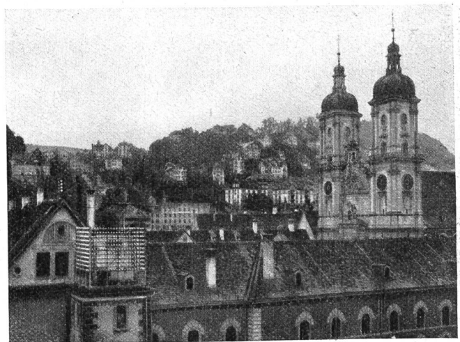
Abb. 1. Regierungsgebäude mit Giebel, in welchem die erste Zentrale untergebracht war. Im Vordergrund der Zentralträger.
