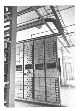
Fig. 2. Répéteurs à deux fils et panneaux d'appel.
