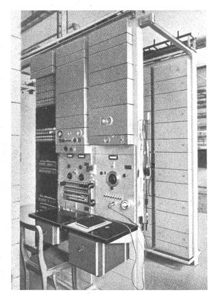
Fig. 8. Baies de mesure et baie des fusibles. Derrière un bâti de translateurs et d'équilibreurs.
