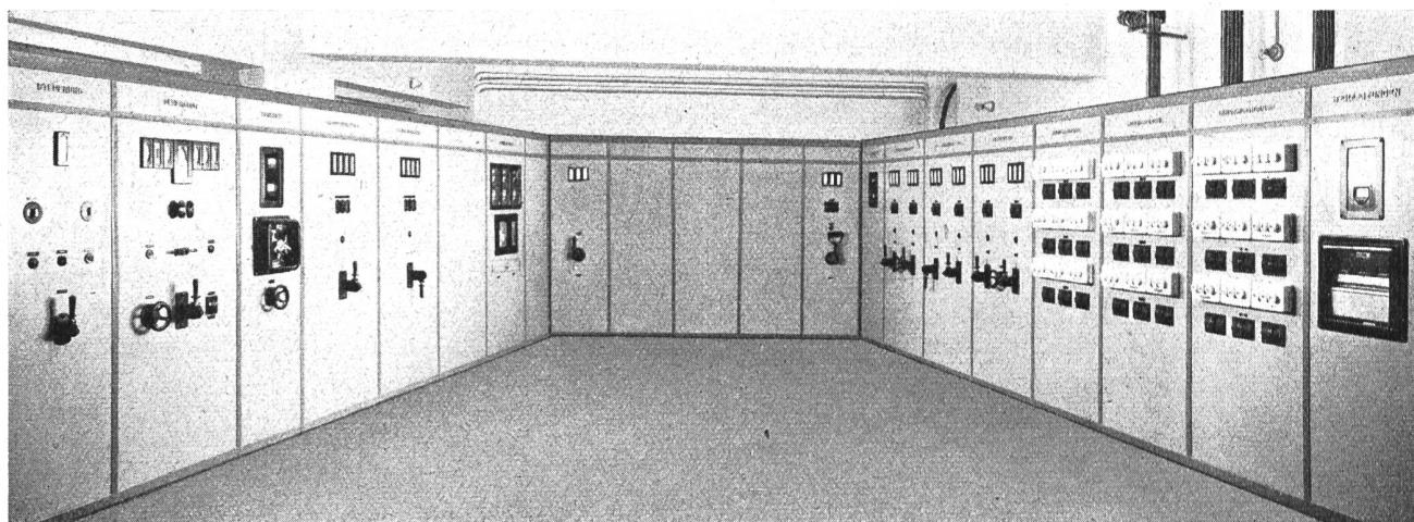
Fig. 9. Der Schaltraum 380/220 V. — Installation de couplage 380/220 V.
