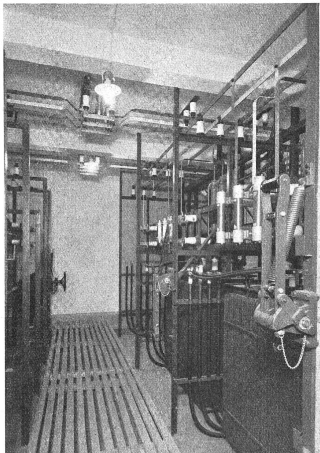
Fig. 6. Blick in die neue Transformatorenstation Hauptpost: Hochspannungsapparate.
