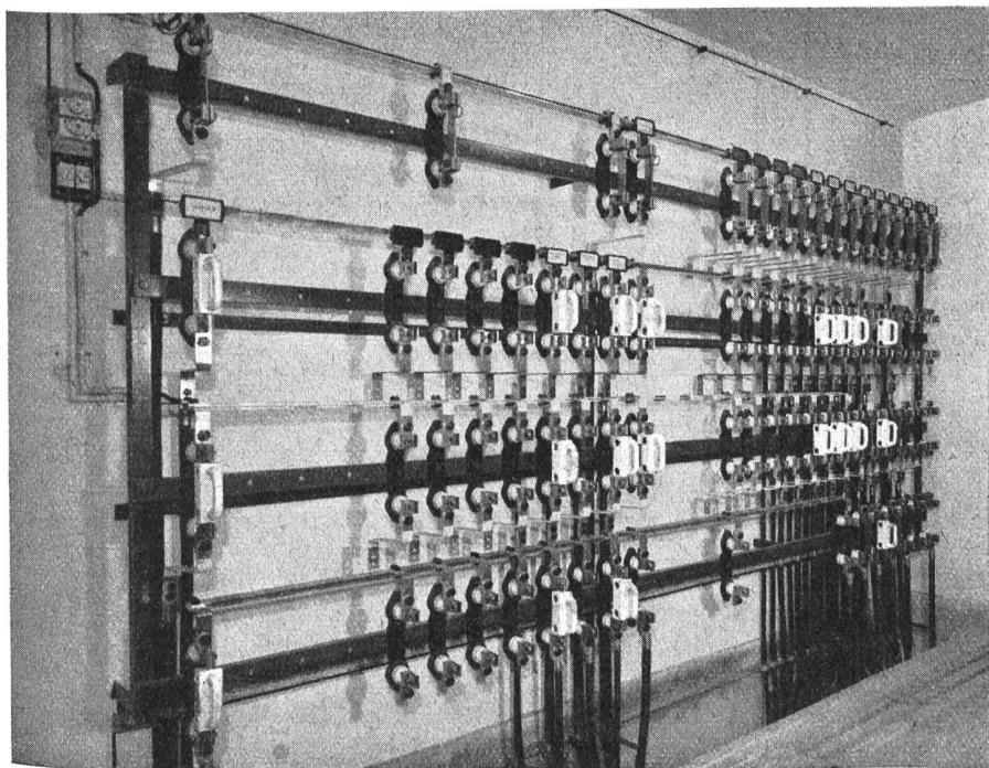
Fig. 7. Transformatorenstation Hauptpost. 380/220 - Volt-Verteilanlage.
