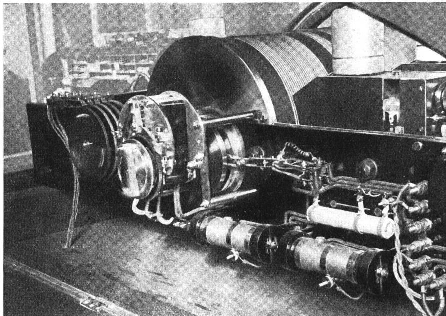
Fig. 7. Seitenansicht der sprechenden Uhr mit Nockenrädern und Synchronisierungsvorrichtung.
