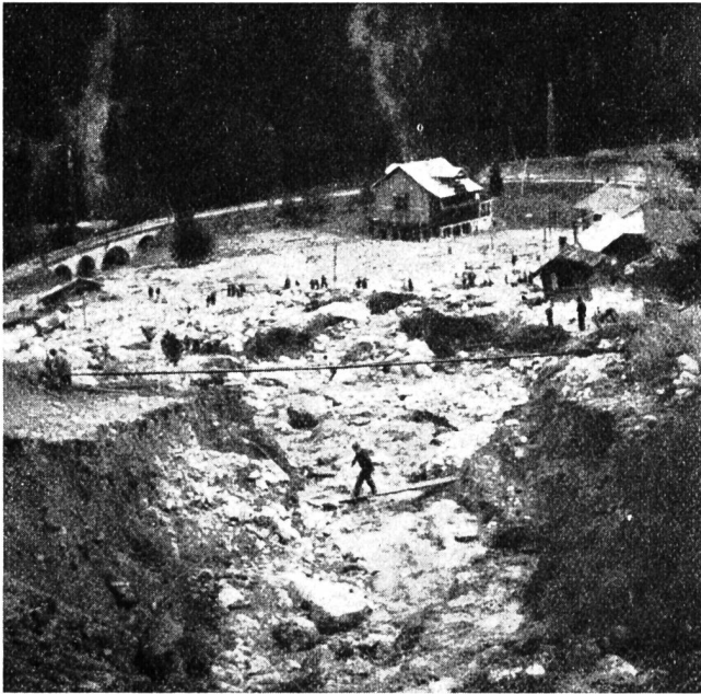
Abb. 4. Fernkabelstörung bei Litzirüti. An Ankerseilen aufgehängter Kabelkanal über dem ausgewaschenen Bachbett.
