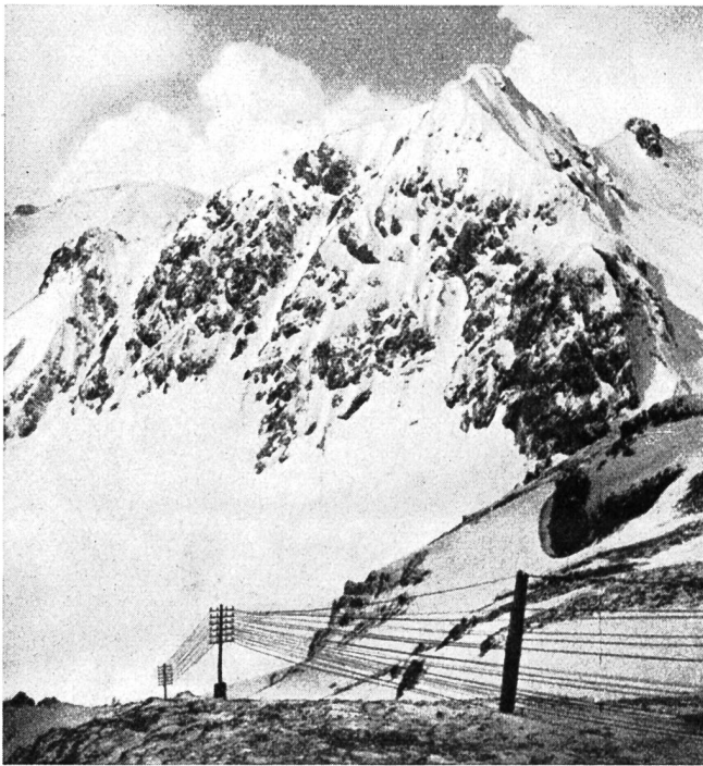
Abb. 1. Fernleitungsstörung auf der Strelapasshöhe. Links Schiahorn.
