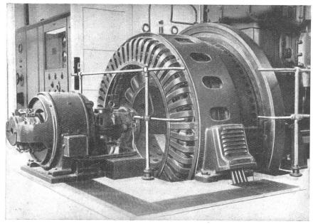
Fig. 8. Dreiphasen-Dieselgenerator 260 kW, 380 V. Generatrice trifase, 260 kW, 380 V, accoppiata al motore Diesel.
