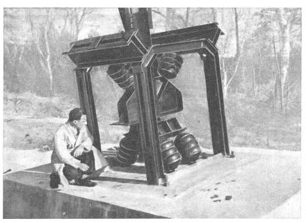
Fig. 6. Turmfuss. — Zoccolo d'isolazione delle torri.
