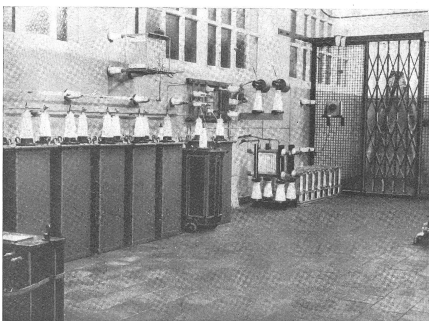
Fig. 9. AnodenspannungsfILTER 15,000 Volt. — Filtro per la tensione anodica 15,000 V.
