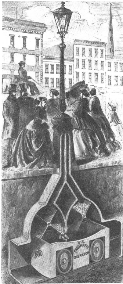
Abb. 6. Automatische Briefkastenentleerung mittels Rohrpost nach A. E. Beach, New York 1867.
