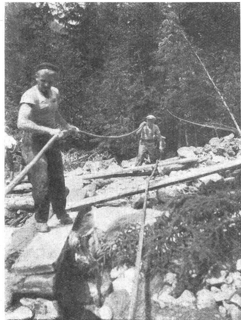
Bild 4. Baukabelauslegung über die Stulsertobelbrüfe.
