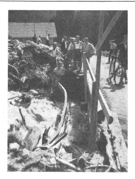
Bild 3. Zerstörte Kabelüberführung über den Monsteinerbach.
