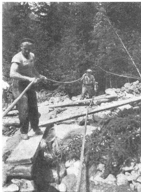
Bild 4. Baukabelauslegung über die Stulsertobelbrücke.
