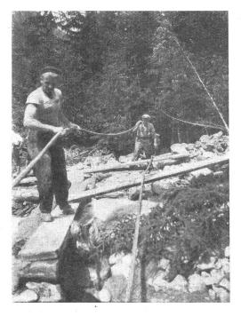
Bild 4. Baukabelauslegung über die Stulsertobelrüfe.
