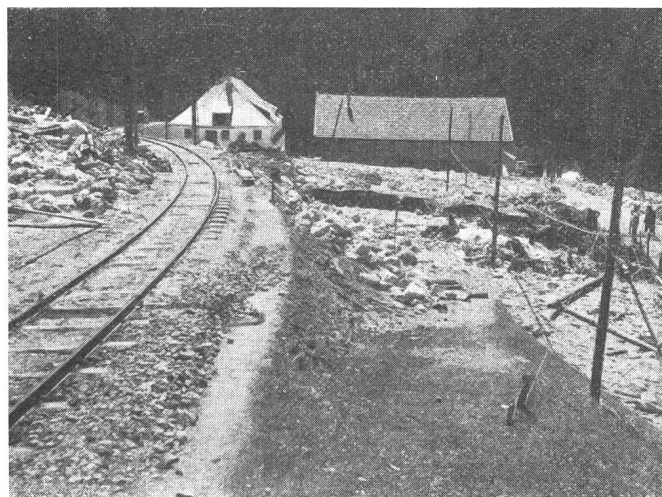
Bild 5. Baukabelaufhängung im Schmelzboden.
