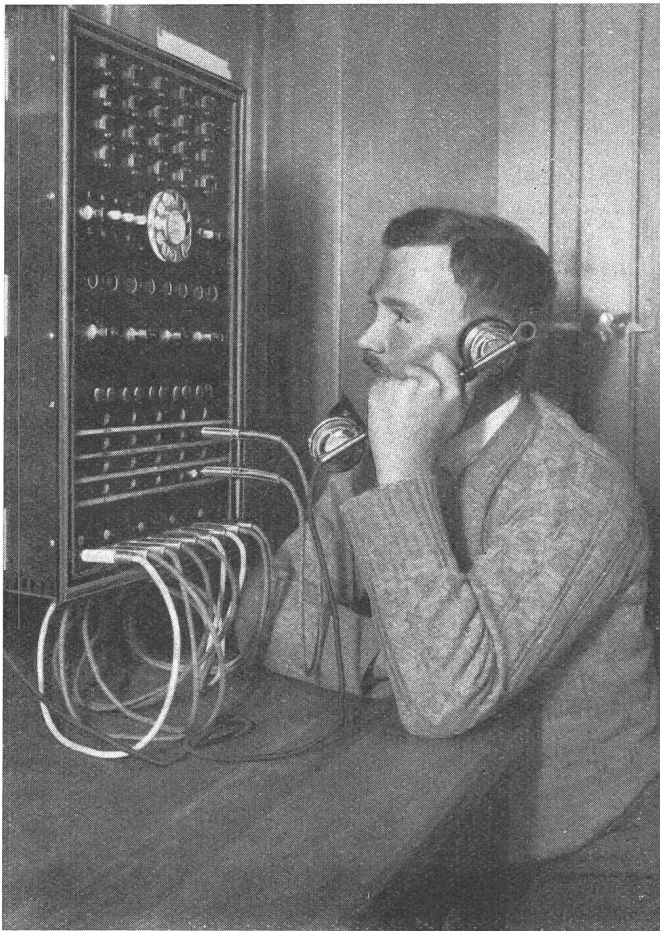
Fig. 10. Vermittlungseinrichtung im Berghaus. Commutateur du Berghaus.
