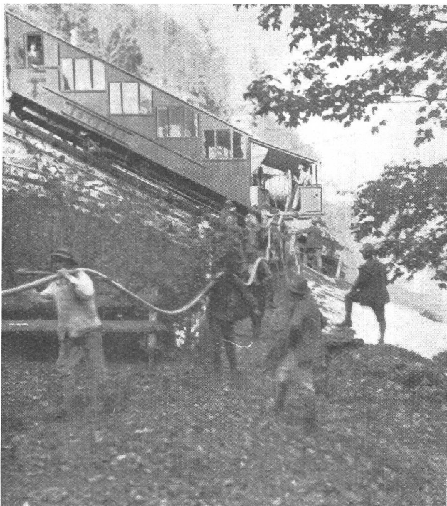
Fig. 8. Kabelaustragung vom Wagen aus. Déroulement du câble depuis le funiculaire.
