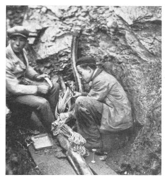
Fig. 9. Spleissarbeit zwischen Felsen. Travaux d'épissure entre les rochers.
