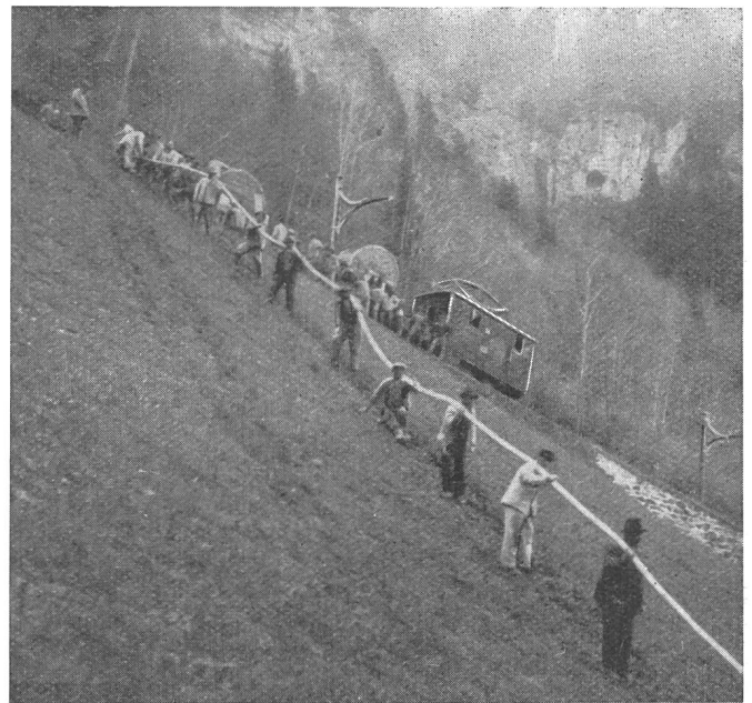
Fig. 2. Kabelastragung oberhalb Lauterbrunnen. Transport du câble en amont de Lauterbrunnen.
