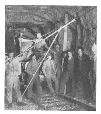
Fig. 5. Kabelauslegung im Tunnel Eigergletscher-Jungfraujoch. Pose du câble dans le tunnel Glacier de l'Eiger-Jungfraujoch.
