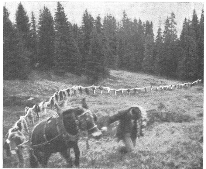
Fig. 7. Kabelaustragung auf der Strecke Lauterbrunnen-Mürren. Transport du câble sur le parcours Lauterbrunnen-Mürren.
