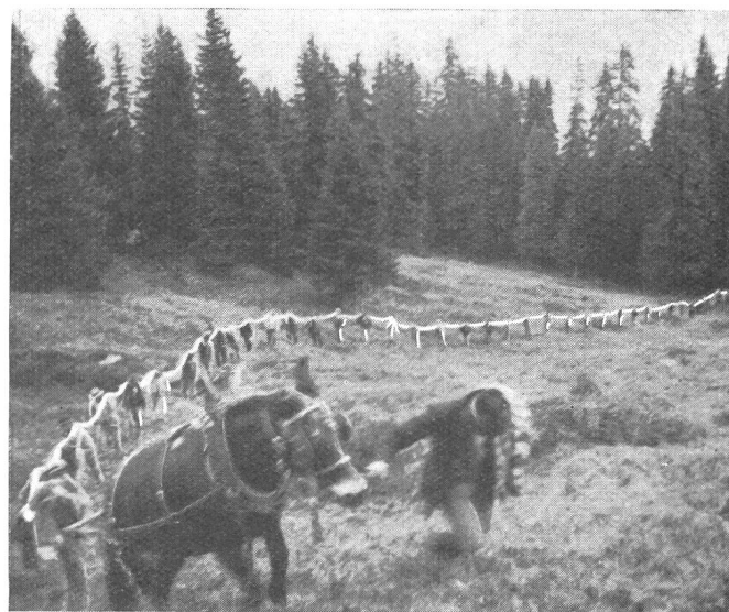
Fig. 7. Kabelaustragung auf der Strecke Lauterbrunnen-Mürren. Transport du câble sur le parcours Lauterbrunnen-Mürren.
