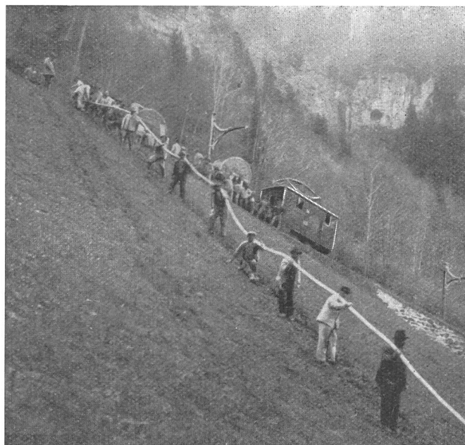
Fig. 2. Kabelaustragung oberhalb Lauterbrunnen. Transport du câble en amont de Lauterbrunnen.
