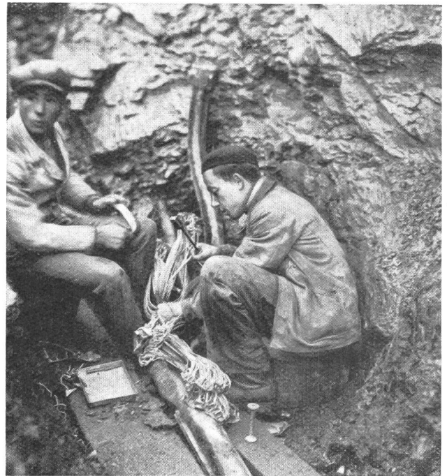
Fig. 9. Spleissarbeit zwischen Felsen. Travaux d'épissure entre les rochers.
