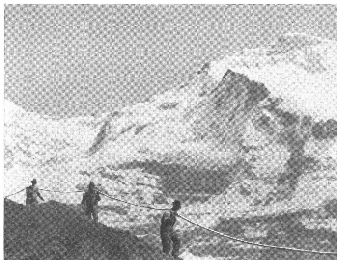
Fig. 4. Kabelaustragung auf der Wengernalp. Transport du câble à la Wengernalp.
