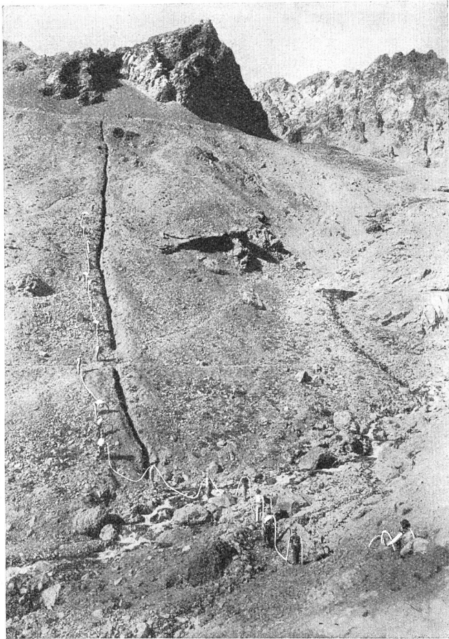
Fig. 4. Le câble téléphonique à travers les Andes.
