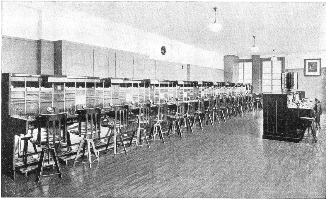
Fig. 28. Fernzentrale. — Central interurbain.
