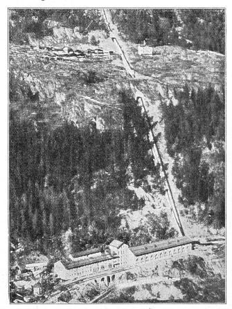
Fig. 6. Usine de la Barberine. Conduite forcée et bâtiment des machines.
