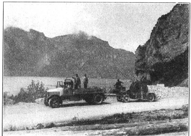
Fig. 15. Kabeltransport an der Axenstrasse.
