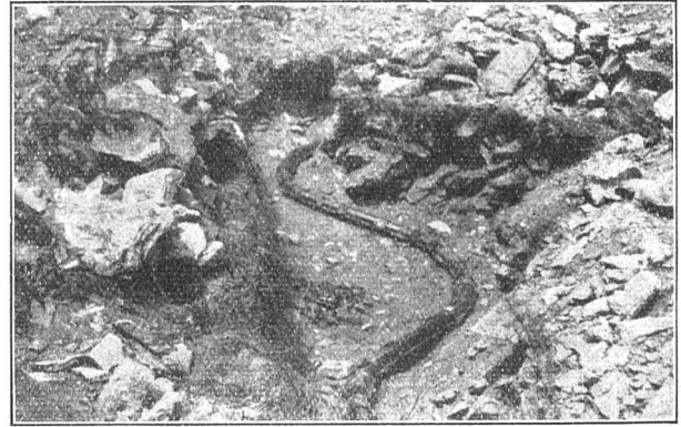
Fig. 21. Ausgleichsbogen vor einer Bachkreuzung.
