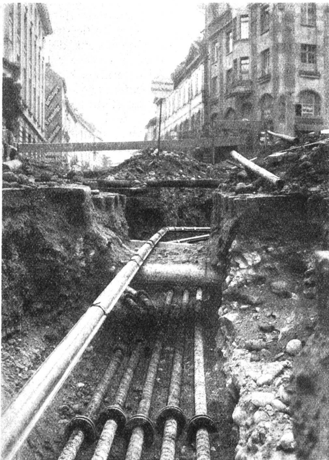
Fig. 2. Verlegung der Fahrrohre. Travaux nécessités par la pose des tubes.
