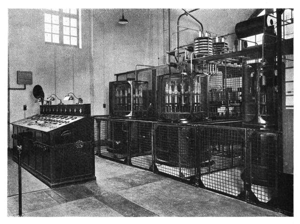
Fig. 3. Radiostation Rugby. Kontrolltisch und Verstärkersätze.
