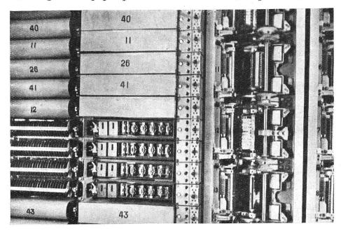
Fig. 18. Sélecteurs de groupes des circuits de jonction, avec relais et combineurs.
