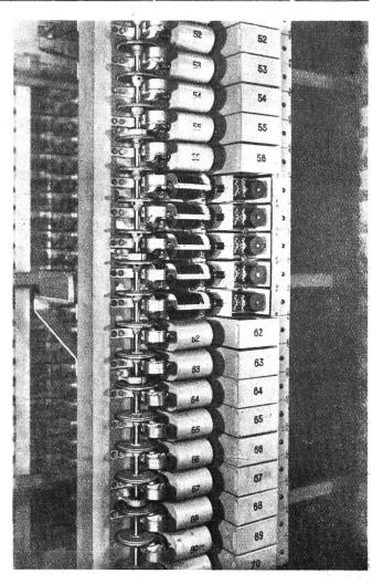
Fig. 11. Combineurs des circuits de jonction de "Birsig".
