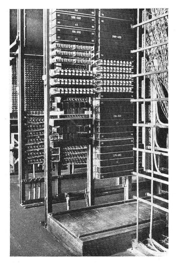
Fig. 6. Ancien distributeur intermédiaire, relais de ligne et de coupure, compteurs, etc.
