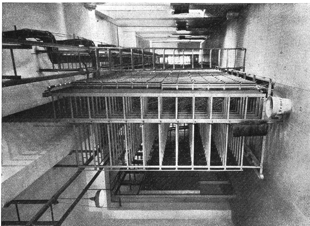
Fig. 10. Hauptverteiler.
