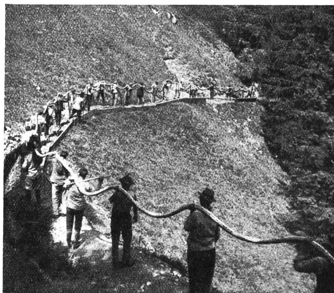
Fig. 5. Kabeltransport. (Aufnahme J. Kamn.)
