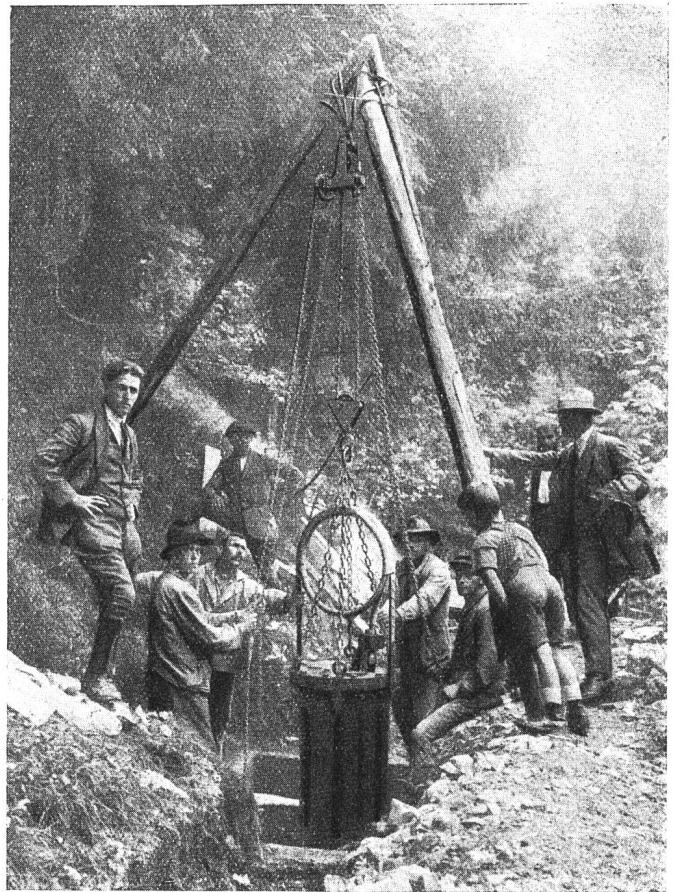
Fig. 9. Versetzen der Pupintöpfe. (Aufnahme J. Kamm.)
