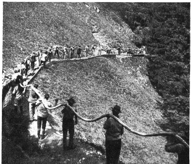
Fig. 5. Kabeltransport. (Aufnahme J. Kamm.)
