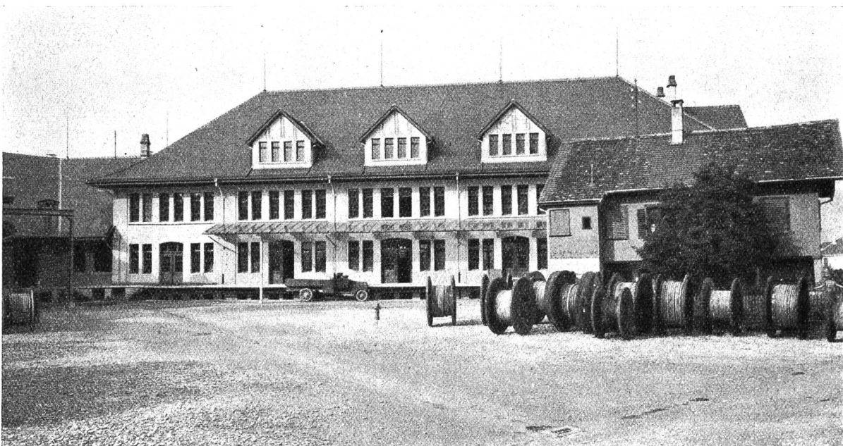
Abb. 13. Hof mit Hauptmagazin, Südfassade und Hauswartwohnung, Südwestfassade.
