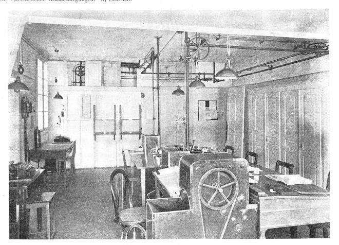
Fig. 5. Telegrammkontrolle mit Förderbandstation und Horizontalseilpoststation.
