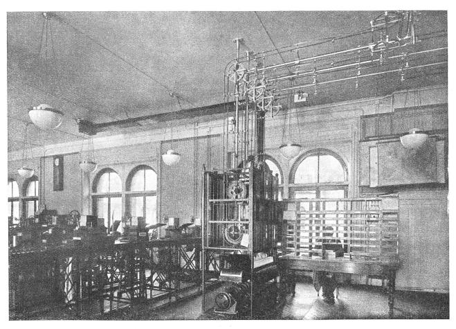
Fig. 2. Seilpost- und Förderbandzentralstation (Seitenansicht).
