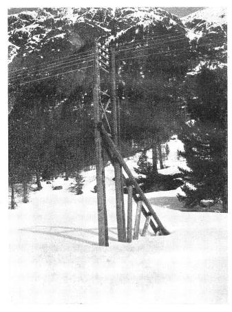
Abb. 3. Doppelgestänge mit Lawinenschutz.
