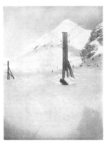
Abb. 4. Keilgestänge nach Niedergang einer grossen Staublawine.
