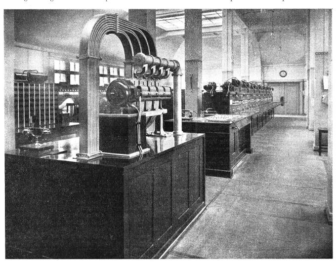
Abb. 8. Rohrpostempfänger und -Sender.
