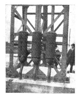
. Fig. 8 Kabel- und Endverschlüsse am Attinghauser-Ständer.
