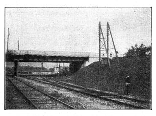
Fig. 10. Gute Lösung. Die Schwachstromleitungen werden in einem Kabel unter der Brücke hindurchgeführt, wodurch der Blick auf der Brücke frei bleibt. — Bonne solution. Les lignes à faible tension sont réunies en un câble qui passe sous le pont, de sorte que la vue du pont n'est pas gênée par elles.
