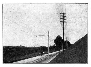
Fig. 16. Fahrdrahtträger und Telephonleitung sind beide in richtiger Weise am aufsteigenden Rand der Straße aufgestellt; dagegen häte das Trottoir an den Anßenrand gehört. Durch die sehwache Biegung des Auslegers gewinnt der Fahrdrahtträger an Gefälligkeit.
