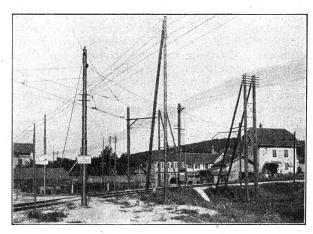
Fig. 11. Durch Häufung verschiedenartiger Leitungen entstandenes, unerträgliches Stangengewirr. — Enchevêtrement affreux de conduites et de câbles les plus divers.
