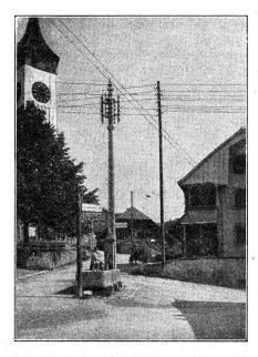
Fig. 6.\*) Unbefriedigende Aufstellung von Masten. Der Gitterträger steht im Kreuzungspunkt zweier Straßen und die hinterste Stange im Gabelungspunkt einer Straße. — Disposition peu satisfaisante de poteaux: Le måt en fer se trouve à l'intersection de deux routes et le plus lointain au point d'embranchement d'une route.
