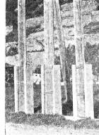
La forme en L présente, comme on le sait, une grande résistance. Elle se prête bien aussi pour la pression latérale des terres. L'inconvénient du socle de M. l'ingénieur Meyer réside dans son adaptation plus difficile aux différentes dimensions des poteaux. Lorsqu'un poteau est d'un diamètre trop fort, il faut réduire la section sur une hauteur de 90 - 100 cm ou bien choisir un type de socle plus grand.
