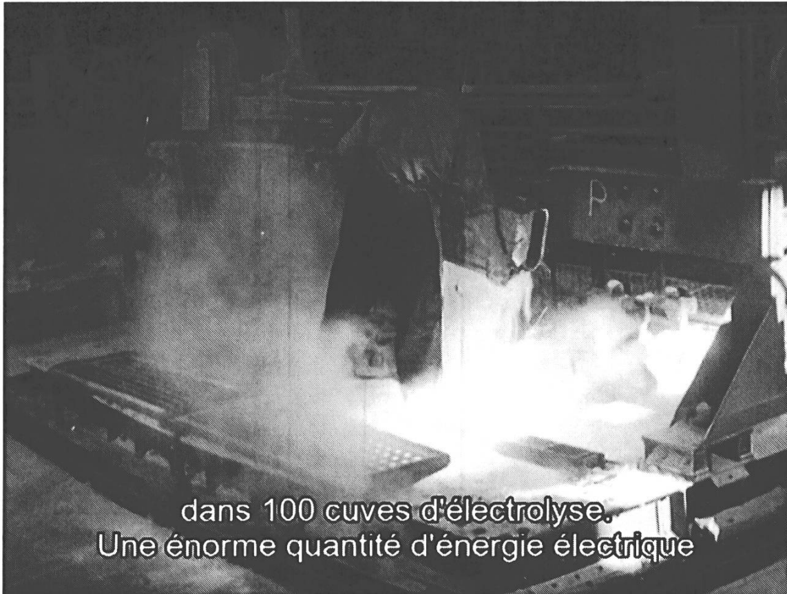
Un ouvrier au travail à Chippis lors du chargement d'alumine dans une cuve d'électrolyse. © Cinéjournal suisse, 13 octobre 1950, 2'40".
