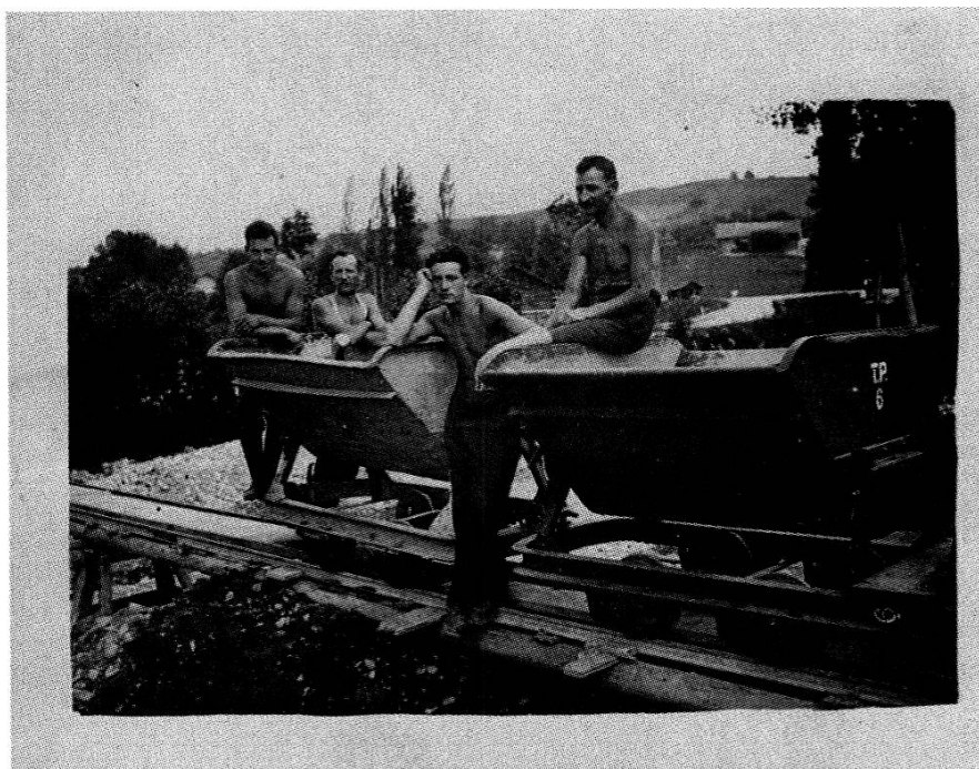
Lucien Tronchet sur un chantier de chômeurs à Perly, 1921. Photo © Collège du Travail.
