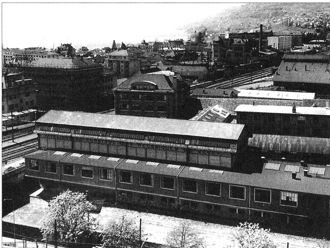
Vue générale des bâtiments situés entre la Veveyse et les rails CFF de la ligne du Simplon (négatif 6 x 6 N° 5669, Studio-reportage Edouard Curchod, Vevey).
