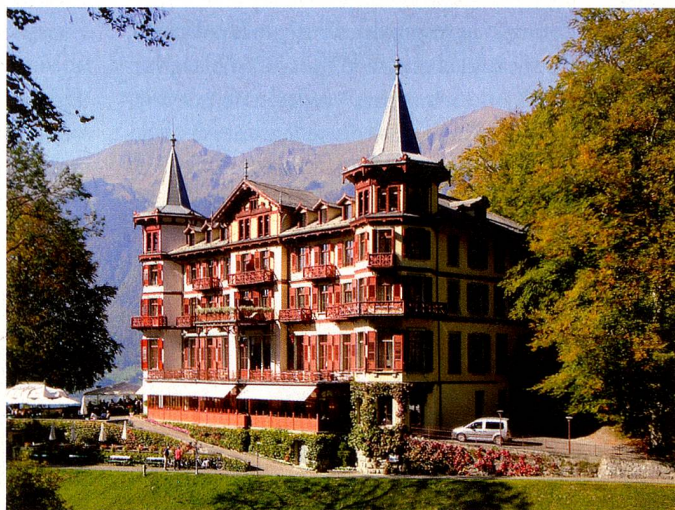
Para salvar el Hotel Giessbach, de la Belle Époque, Franz Weber creó en 1983 la fundación “Giessbach para el pueblo suizo”
