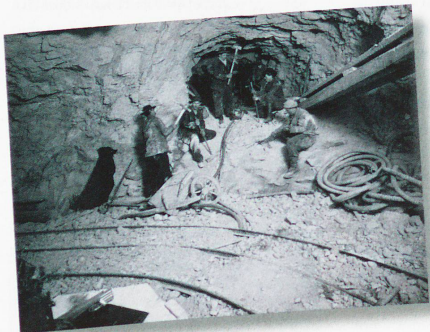
Mineros construyendo el túnel, poco antes de la perforación en el Jungfrauoch, el 21 de febrero de 1912
