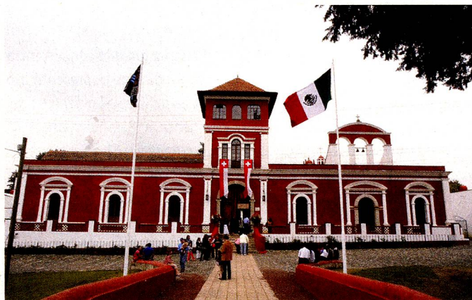
Fachada de la Hacienda de Panoaya - México
