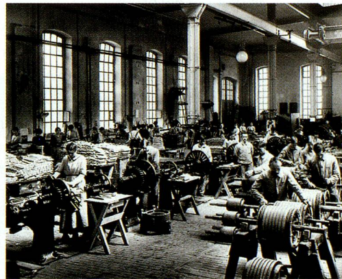
1915: Fábrica de BBC en Münchenstein. Acabado de las bobinas que se montaban en los motores de las locomotoras.
