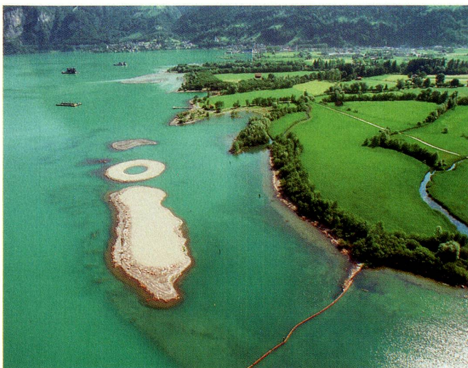
Terraplén y excavaciones del Gotardo en el delta del Reuss, junto a Flüelen.
