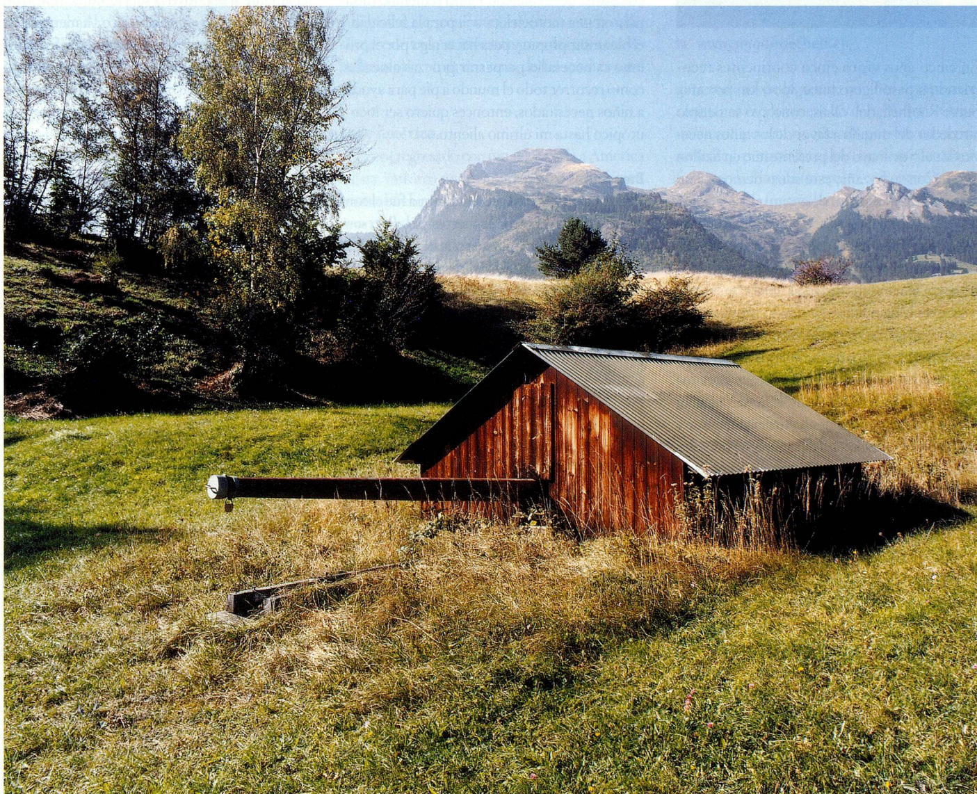
Choza, 1939-43, Torre blindada de la fortaleza de Magletsch, Oberschan SG: La torre blindada está cubierta por un encofrado de madera y un techa de chapa ondulada. El cañón no está revestido y lleva una tapa en su boca.
