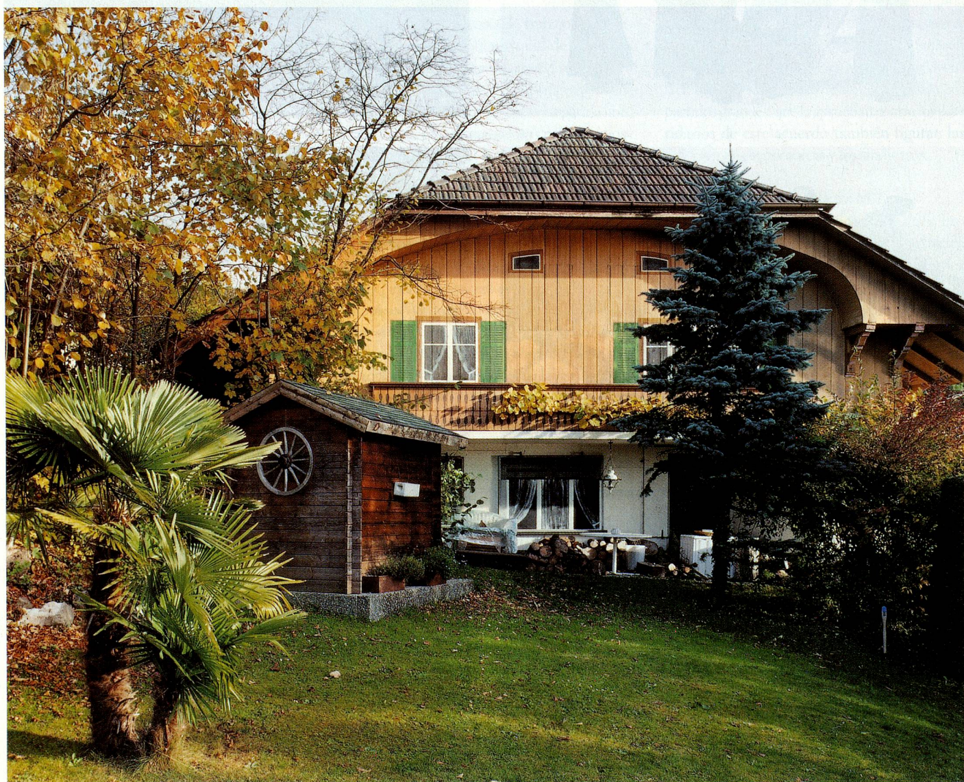
Chalet, 1941, búnker de infantería, Hilferfingen BE: construcción de hormigón con techo de copete truncado e interior abovedado. Las ventanas, los postigos y la barandilla de balcón están pintados sobre el recubrimiento de madera. Bajo el retroceso se encuentra la tapa de la tronera que parece una ventana con persianas semiabiertas.
