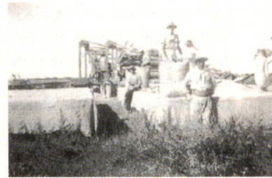
Trilladora Casse de 24 pulgadas de cilindro con la que se trillaba la cosecha fina
