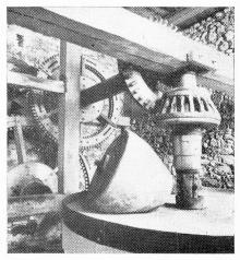
Trituradora de cáñamo, accionada hidraulicamente, en las afueras de la aldea Hettlingen.
