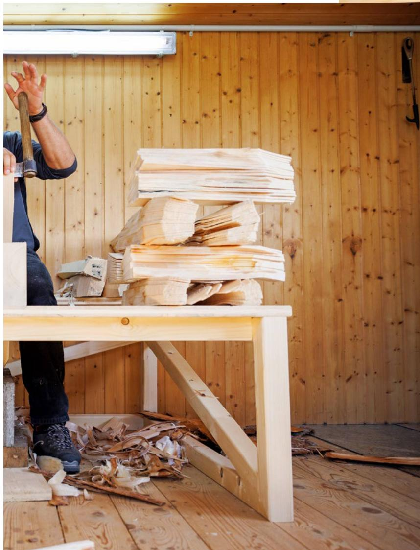
«Ein Schindeldach hält 35 bis 40 Jahre. Das entspricht etwa der beruflichen Laufbahn eines Schindelmachers. Es kommt deshalb selten vor, dass ein Handwerker noch arbeitet, wenn eines seiner Werke erneuert werden muss.»
