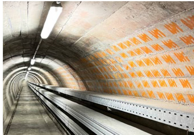
20 000 Striche an der endlosen Tunnelwand illustrieren, für wie viele Menschen die Anlage geplant wurde. Foto Stéphane Herzog
