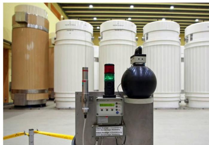
Behälter für hochradioaktive Abfälle im Zwischenlager Würenlingen – mit Überwachungsmessgeräten im Vordergrund. Bild Keystone
