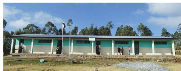
Fertiges Schulhaus 2016 mit 4 Klassenräumen zu 60 Plätzen
