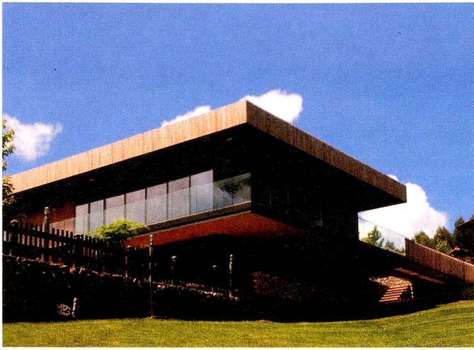
Viel Holz und Glas: Casa Vita - das erste Haus mit Minergie-Zertifikat in Spanien Beaucoup de bois et de vitres: Casa Vita - la première maison avec un certificat Minergie en Espagne
